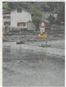
Baustelle im Ortskern
