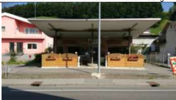
Brunos Pizzeria Weiler – ehemalige Tankstelle
