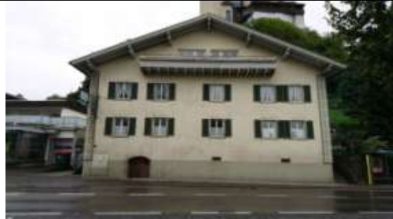
Ehem. Gasthof Engel Rankweil – heute Wohnhaus
